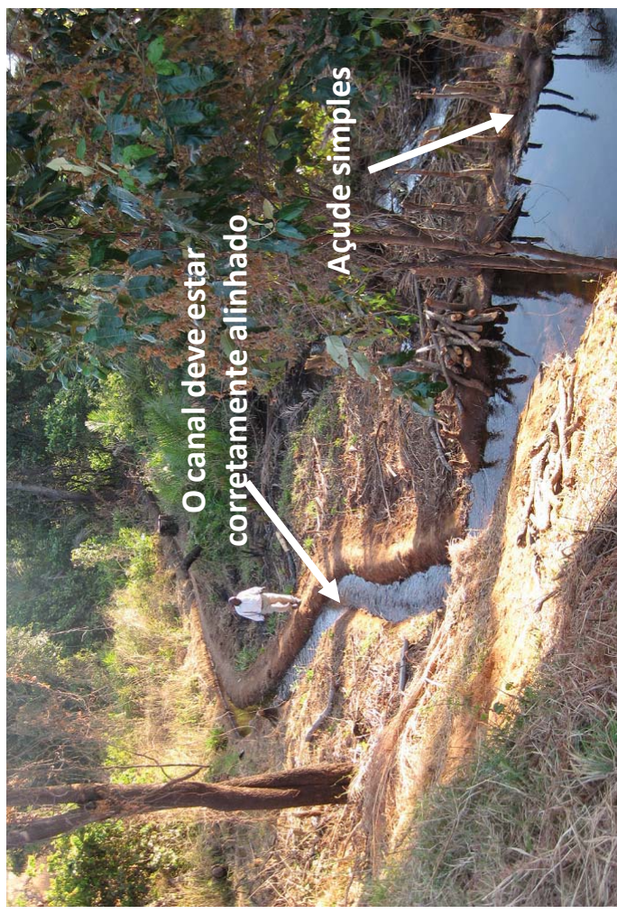
Alinhamento do canal com o nível de bolha de ar
