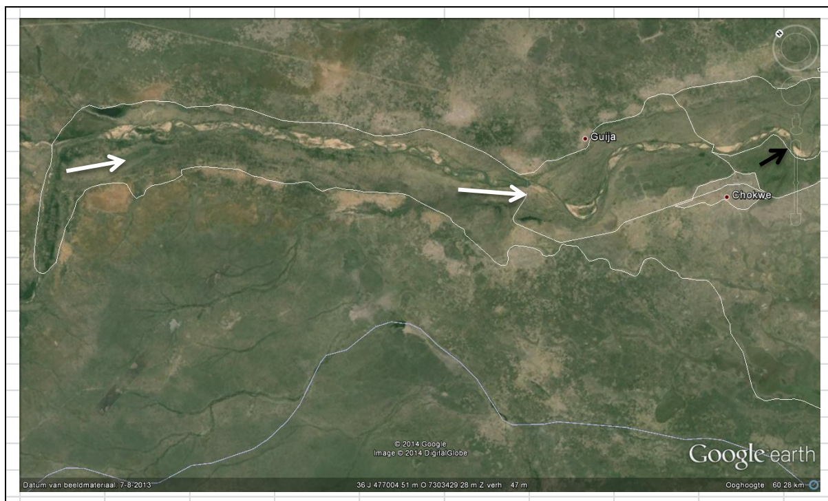
Figura 3.7: Inundação do regadio de Chokwé.
