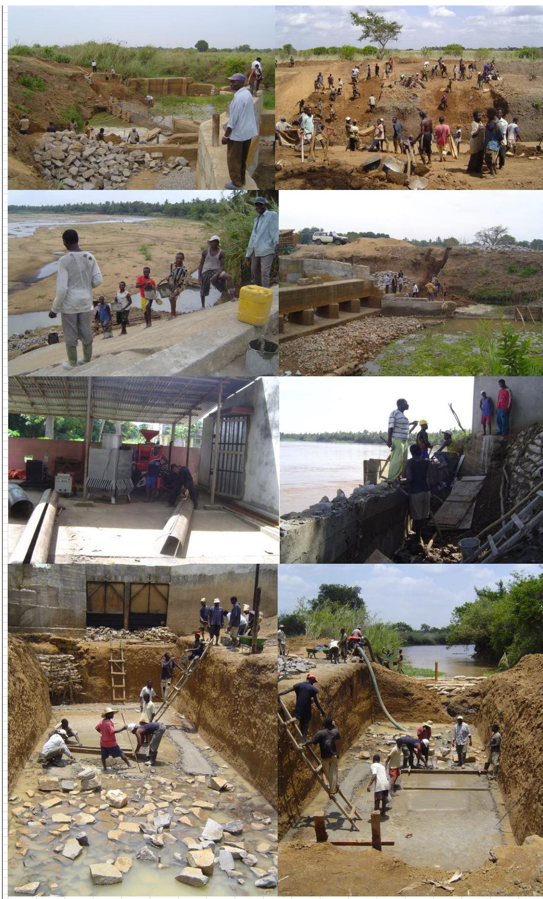
Figura 8.1: construção de obras de irrigação e drenagem em regime directo com mão-de-obra intensiva
