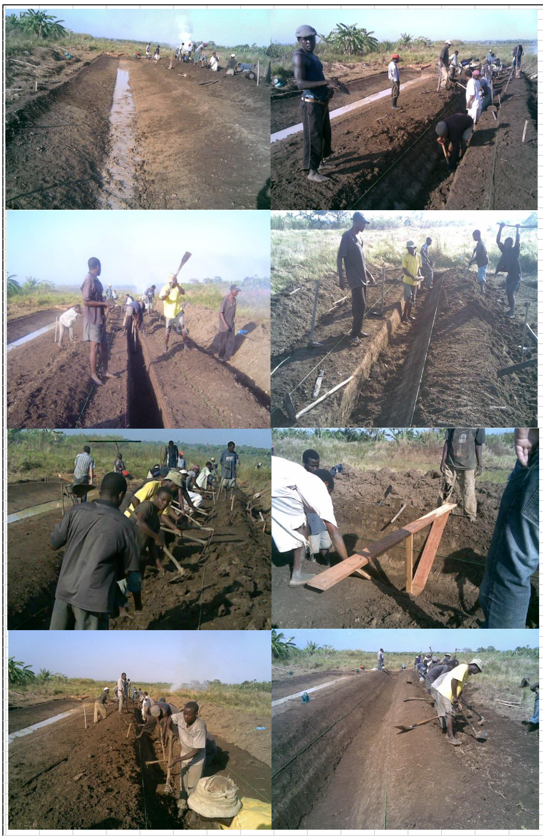
Figura 8.12: construção de canais terciários de irrigação e drenagem
