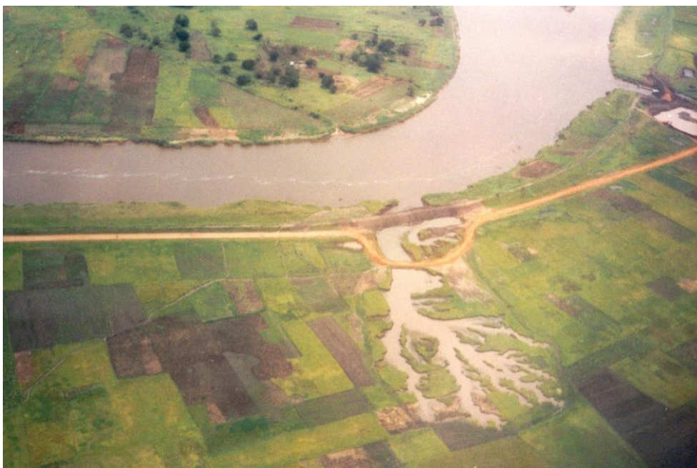
Figura 3.14: Brecha ao longo Rio Limpopo e a sua reparação.
