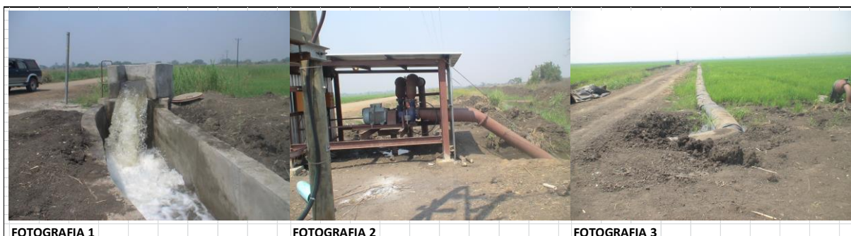
Figura 2.3: Situações no regadio de Thewe em que a água de rega é bombada do rio Zambeze, depois transportada e passada para o canal de drenagem (fotografia 1) para ser depois bombada de novo (sob pressão fotografia 2) através dos tubos flexíveis (fotografia 3) para os campos de arroz.
