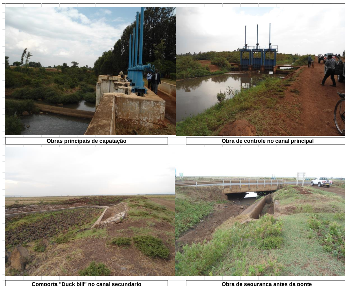
Figura 9.5: Obras características do regadio de M'wea (lit nr. 211).
