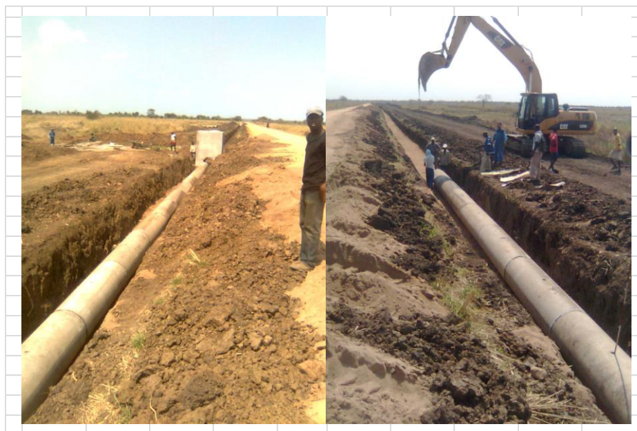
Figura 2.2 : Montagem da linha principal subterrâneo no regadio de Thewe.
