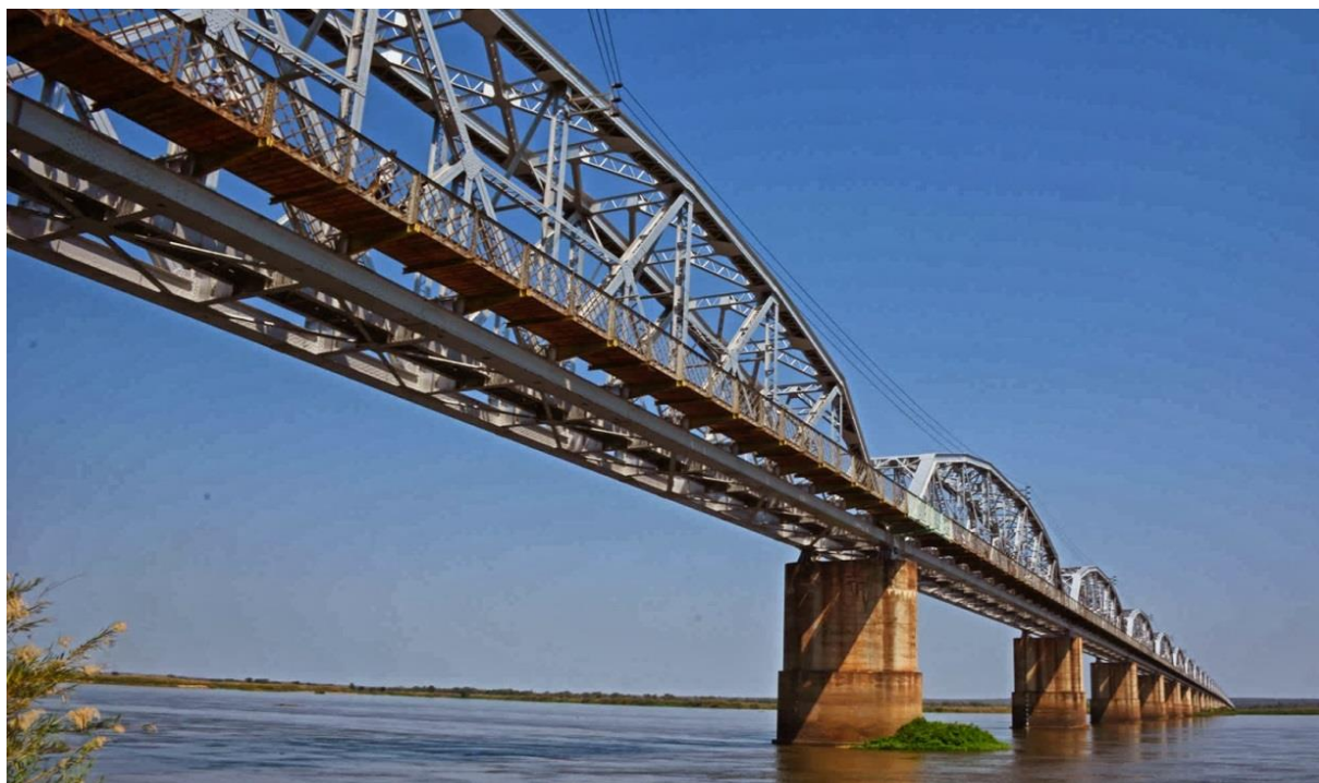
Figura 3.19 : Ponte Dona Ana cruzando o Rio Zambeze (Sena – Mutarara) sem provocar impedimento para as águas das cheias.
