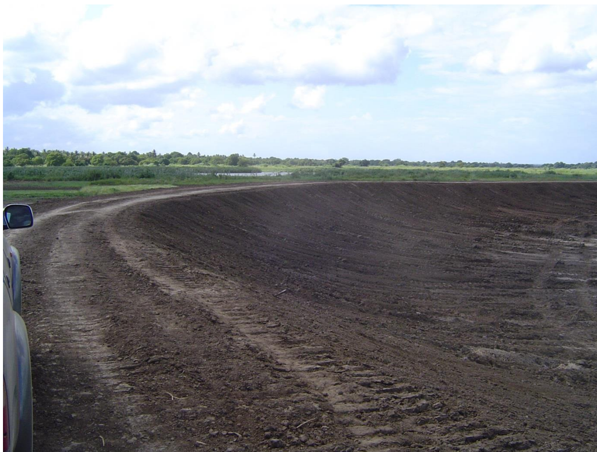
Figura 8.13: Construção de dique de defesa contra cheias mecanicamente.
