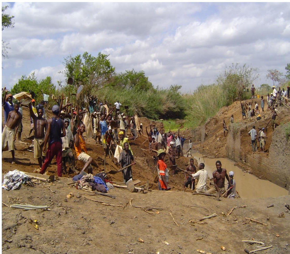
Figura 8.7: Escavação dos taludes.
