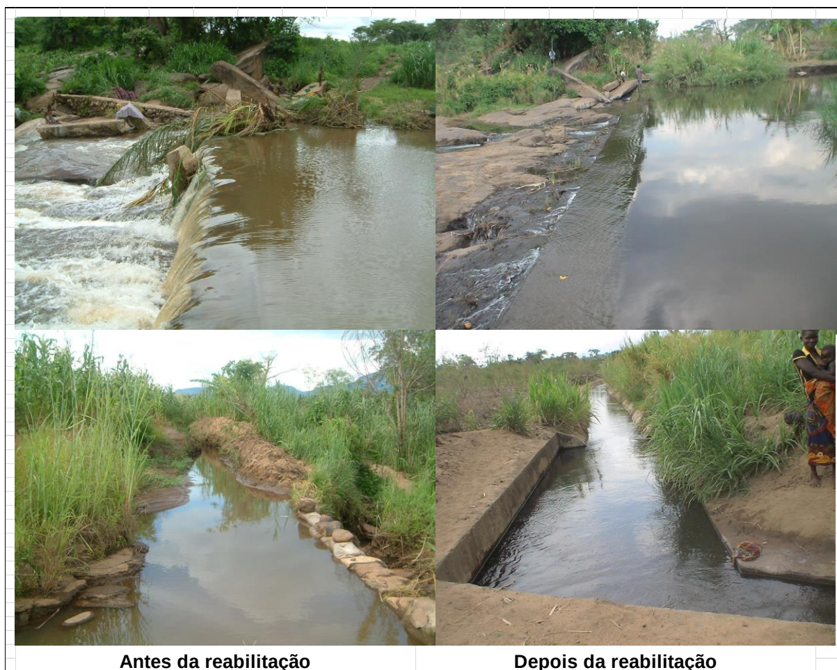
Figura 7.2: Canal e barragem de Nintulo antes e depois da reabilitação.
