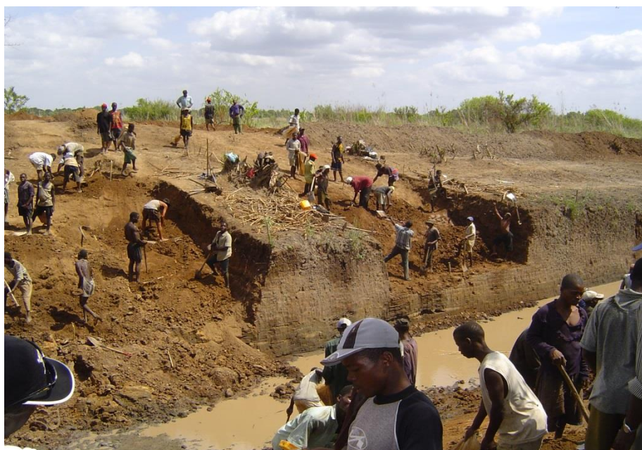
Figura 8.18: A escavação e movimento de terra organizado por grupos de pessoas com suas próprias metas.
