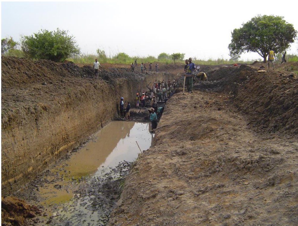
Figura 8.5: Escavação do perfil rectangular do canal de alimentação no Baixo Licungo
