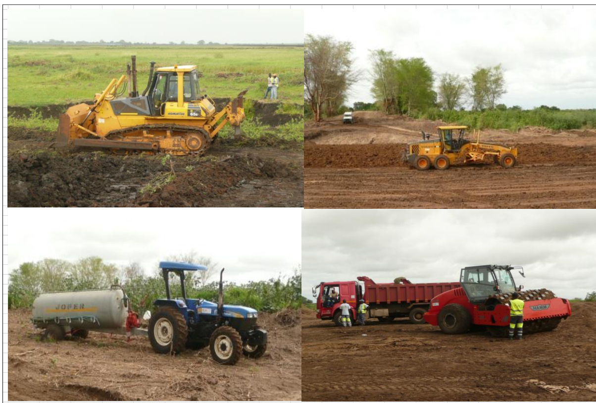
Figura 8.14: Equipamento na construção de diques no vale de Limpopo (vide anexo 5).
