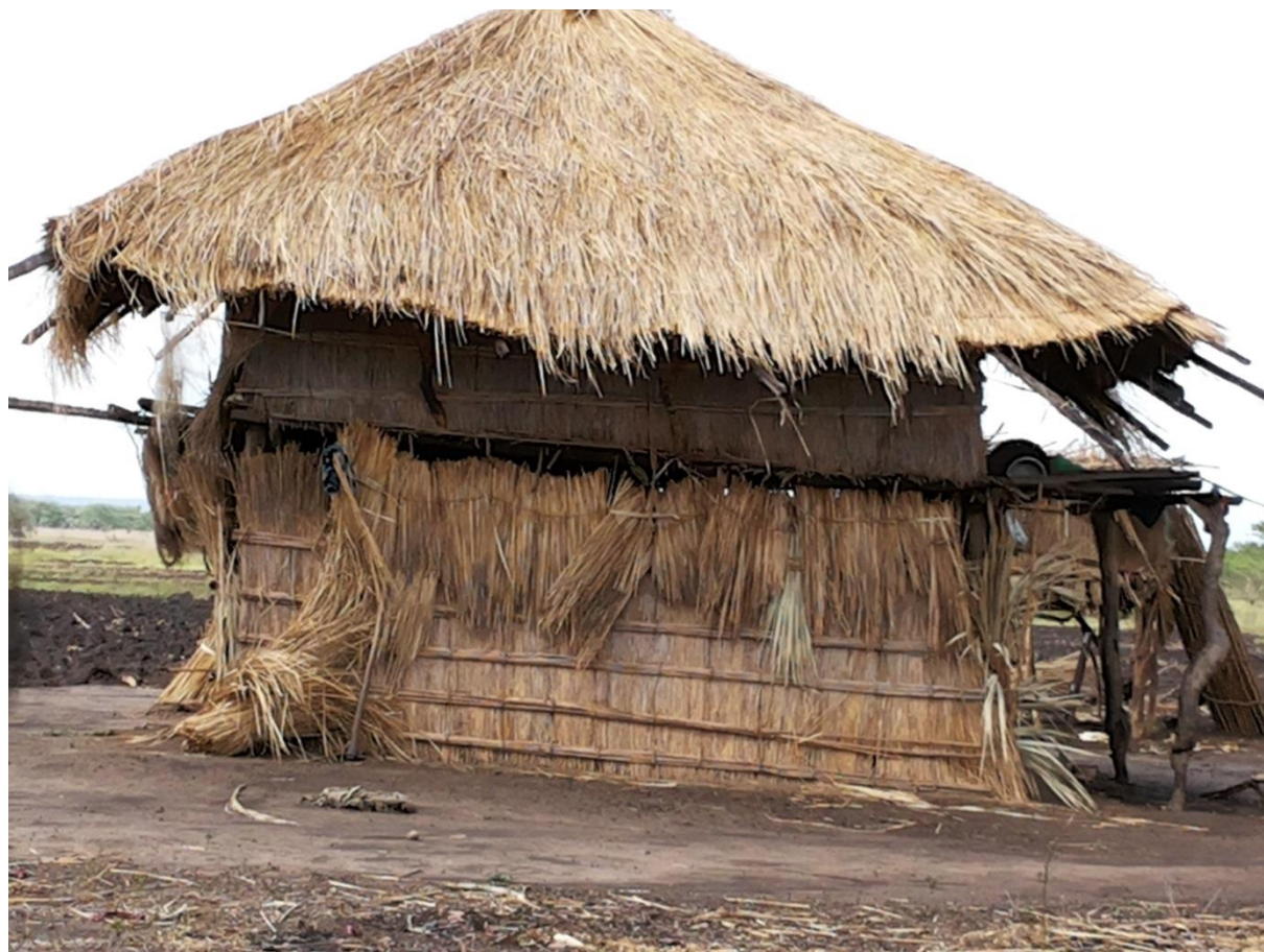
Figura 6.26: Casa de primeiro andar como prevenção contra cheias na planície fluvial a jusante do ápex do delta do Rio Zambeze.
