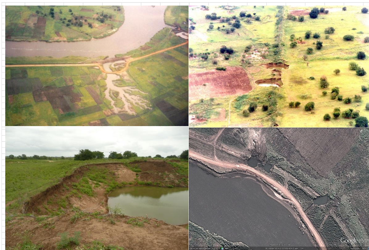
Figura 6.16: Danificações de diques pelas águas das cheias (vide anexo 5 e lit. nr 9).
